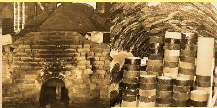
传统的中国龙窑，填充口及用电高频瓷填充的方法 (私人收藏)
